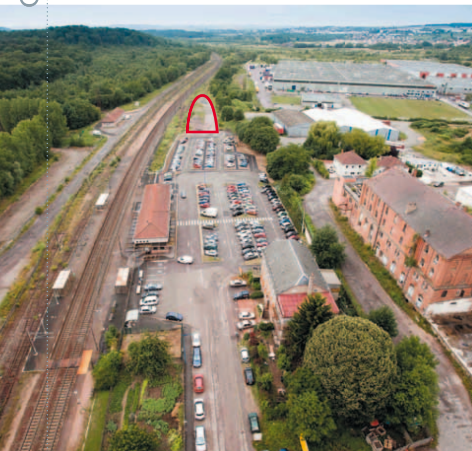
En rouge sur la photo, la troisième tranche de travaux à l'étude.
