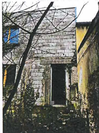
Arrière du garage : n°35
