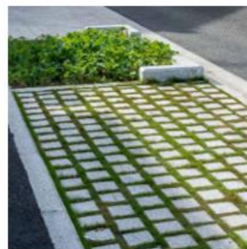
Pavés à joints engazonnés
