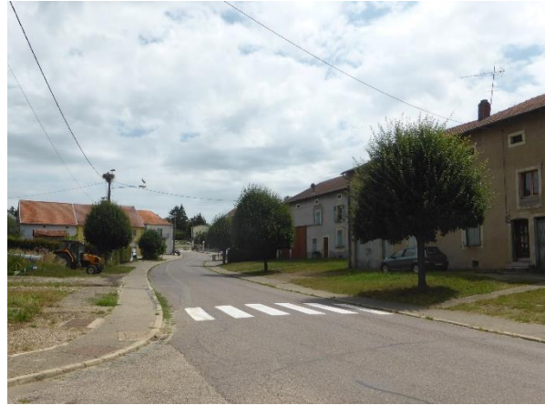
Figure 61 : Vue de la rue de la Libération
