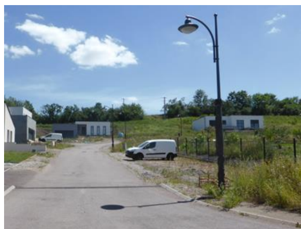
Figure 57 : Vue du versant en amont du lotissement
