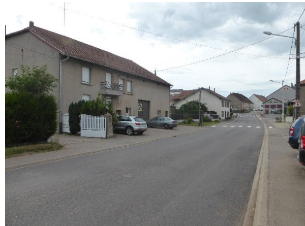
Figure 66 : Vue de la Grande Rue au niveau du désordre
