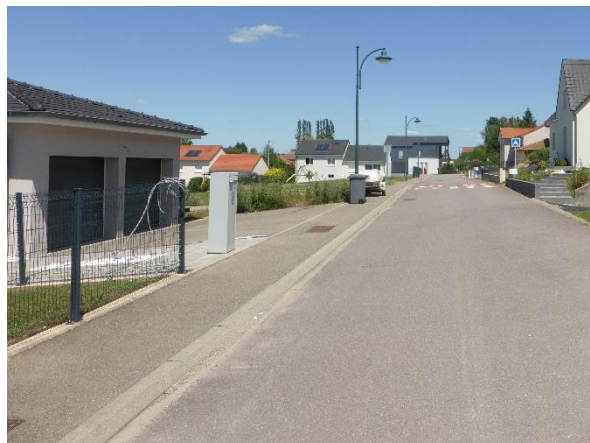
Figure 59 : Habitation construite plus bas que la chaussée (à gauche)
