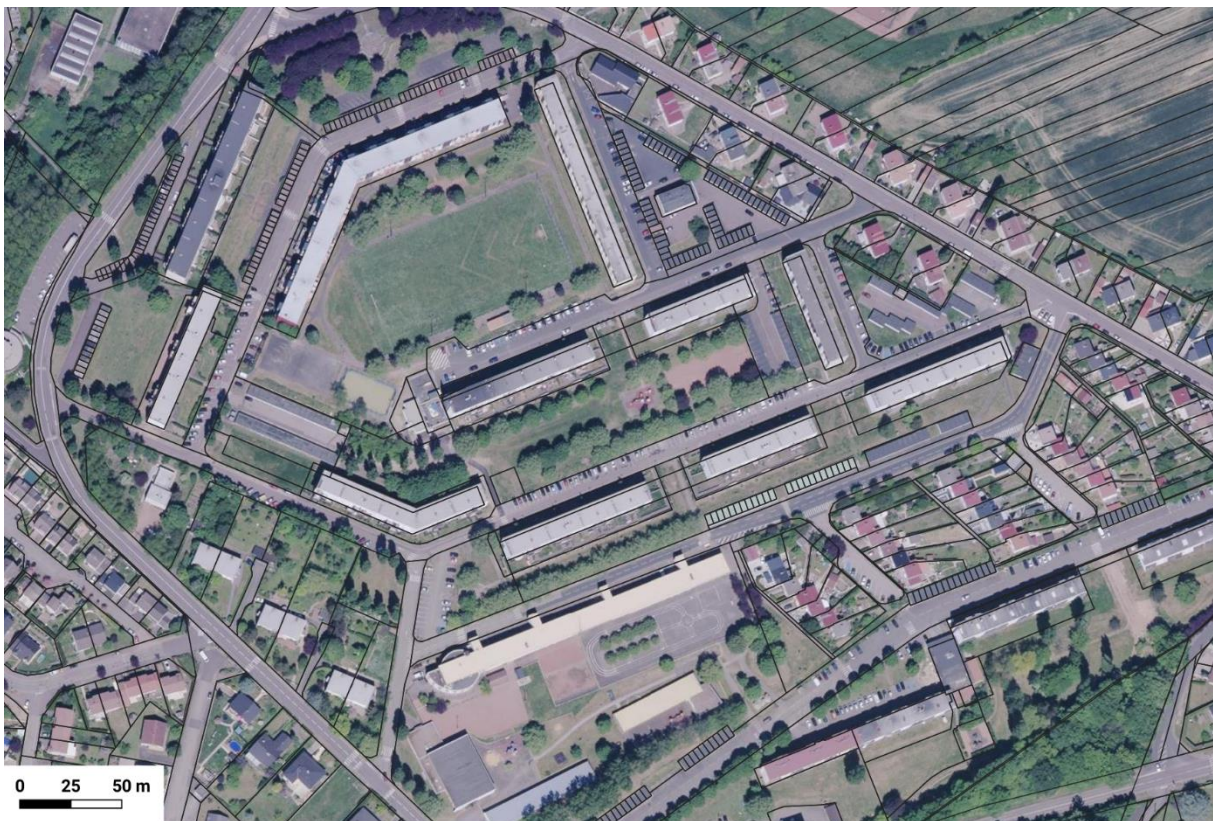
Figure 18 : Bâti collectif – Quartier du Wenheck à Saint-Avold – source : IGN
