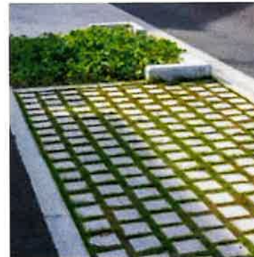
Pavés à joints engazonnés
