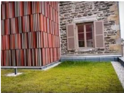
Toiture végétalisée (source : Grand Lyon)
