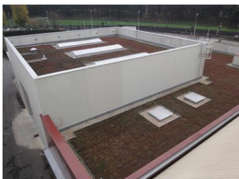
Toiture terrasse stockante
