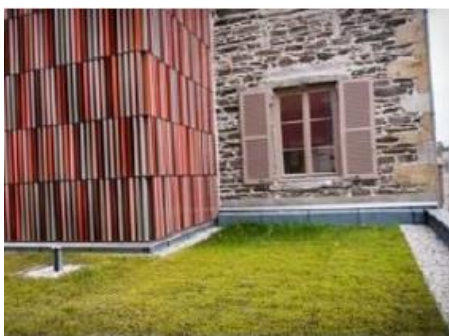
Toiture végétalisée (source : Grand Lyon)
