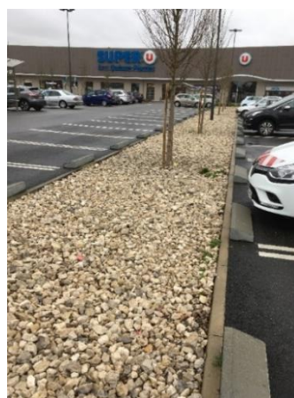
Tranchée d'infiltration (source : SEPIA Conseils)
