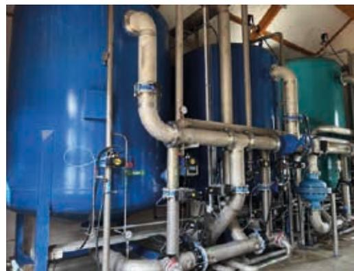
Remplacement des tuyaux INOX des filtres sur la station de traitement et remise aux normes du système d'injection de soude sur la station de Dourd'hal.
