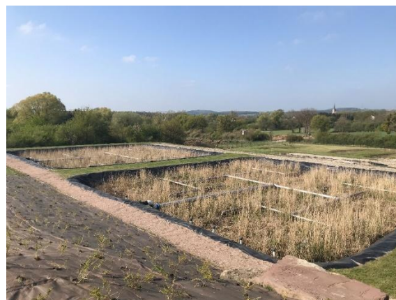
Filtre planté de roseaux – Altrippe Leyviller – 1 er étage
