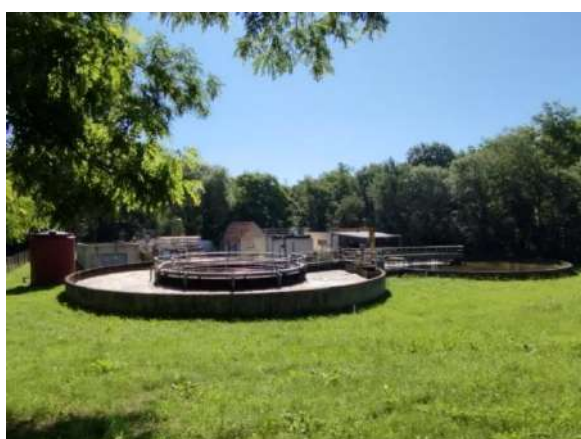
Boues activées – Carling – L'Hôpital
