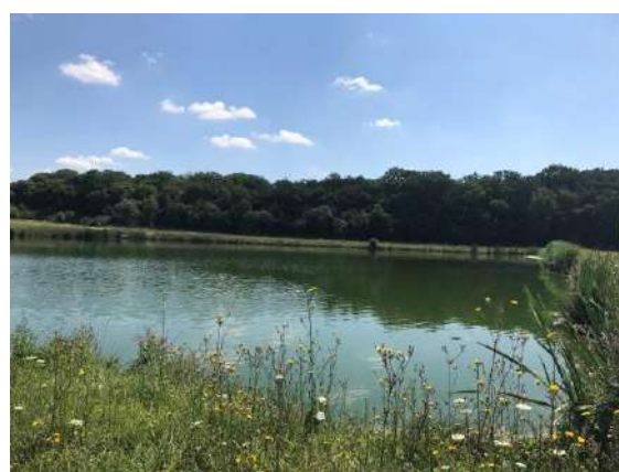
Lagune - Laning - Lixing-Les-Saint-Avoid – Bassin 1
